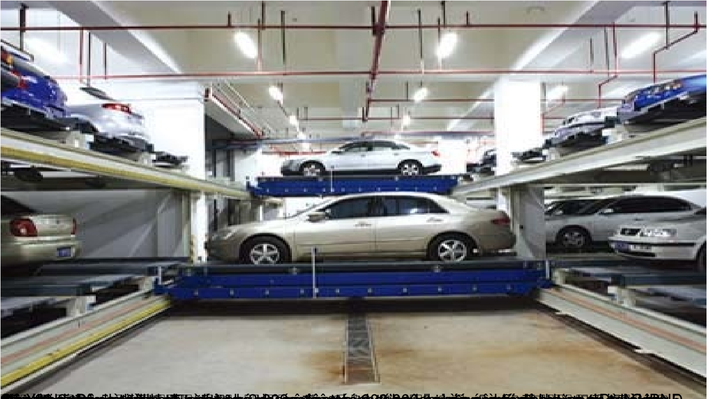
Hình 1.2.1. Hình ảnh công trình bãi đỗ xe ngầm tại Trung tâm Thương mại và Văn phòng của Công ty Cổ phần Đầu tư và Phát triển Đà Nẵng.
